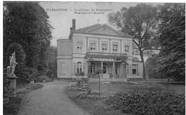
Voorgevel met kleine uitbouw rechts
